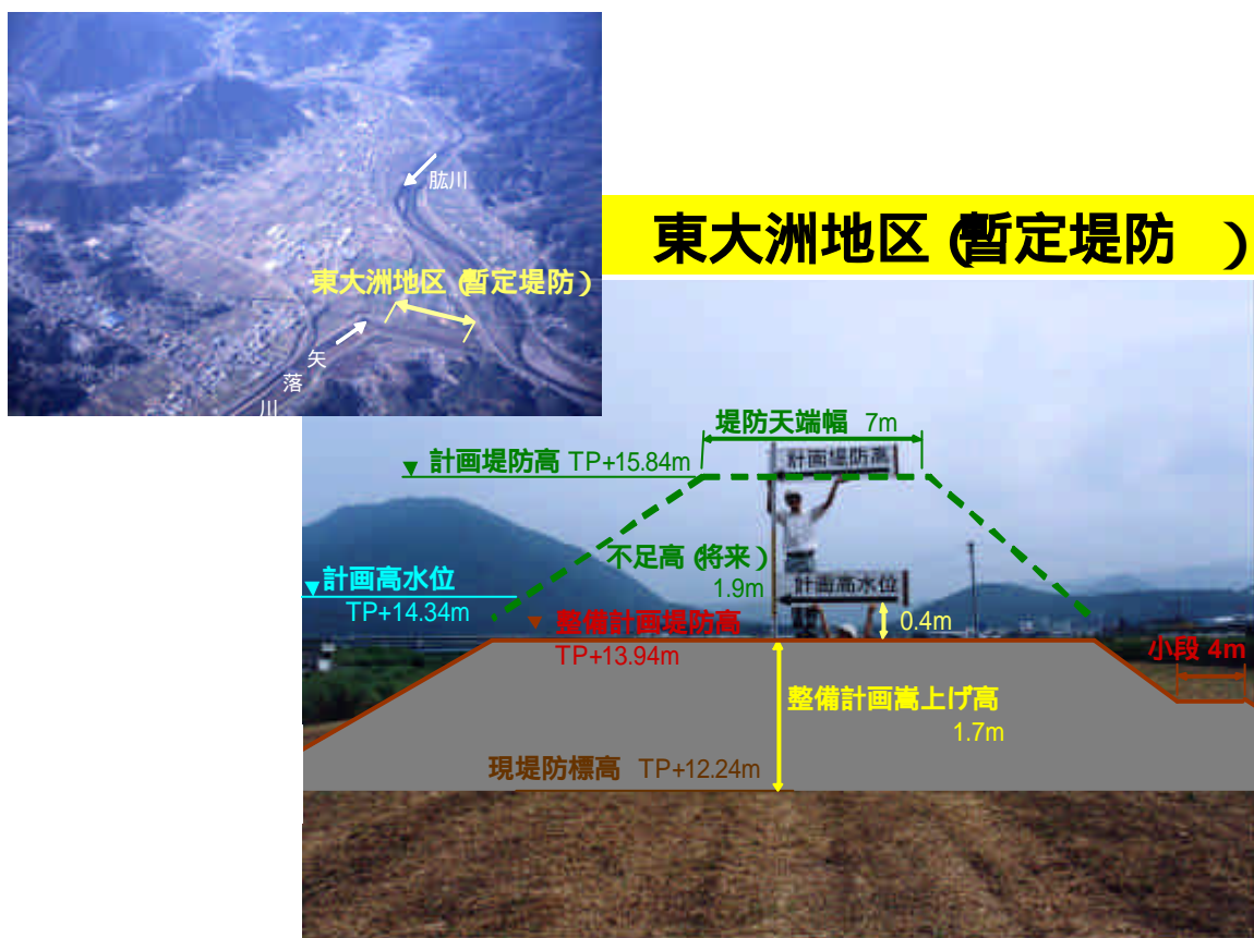
写真 3.1.4 東大洲地区暫定堤防
