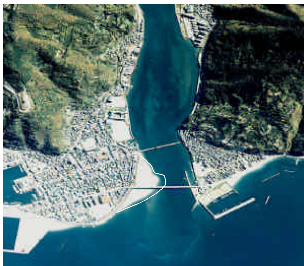
写真 2.1.2 河口砂州フラッシュ状況（平成7年7月洪水後） （点線はフラッシュ前の砂州汀線）
