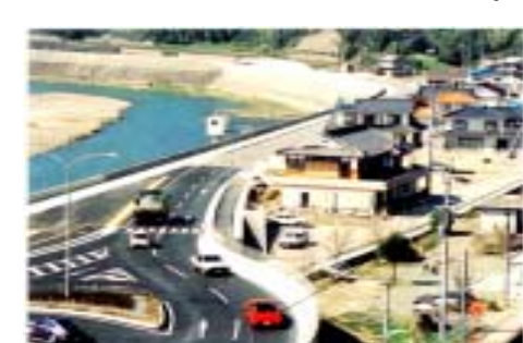
五郎駅前地区完成(上流より)
