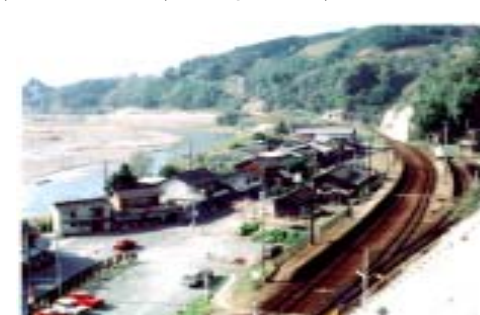
五郎駅前地区施工前(上流より)
