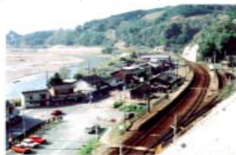
五郎駅前地区施工前(上流より)
