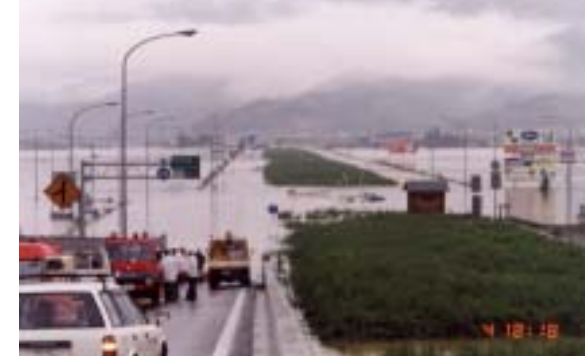
大洲道路浸水状況
