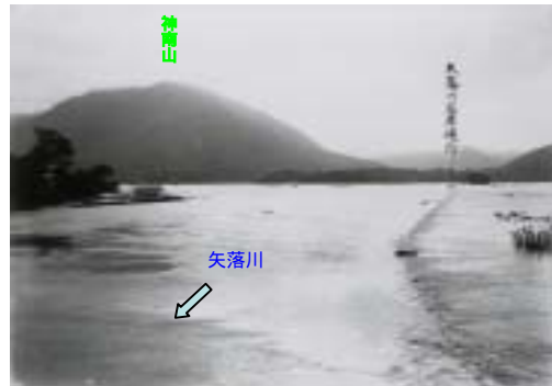
昭和10年8月29日 肱川の増水により矢落川の旧堤（約1.7m）を越流し、大洲平野に氾濫している状況写真
