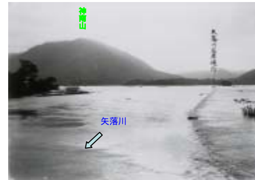
昭和10年8月29日 肱川の増水により矢落川の旧堤（約1.7m）を越流し、大洲盆地に氾濫している状況
