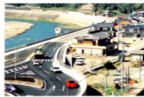
五郎駅前地区完成(上流より)
