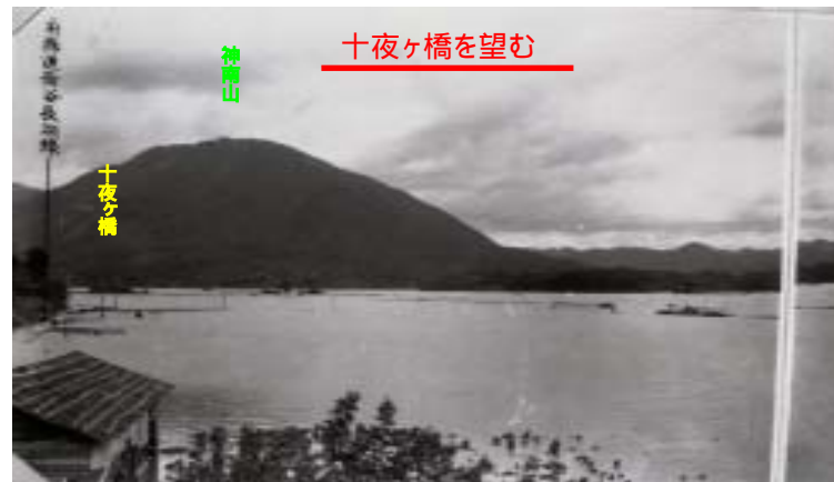
昭和9年9月21日（室戸台風）現存する最も古い大洲平野の浸水状況写真
