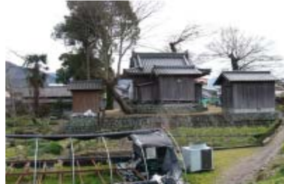
写真 1.2.4 水防場（須賀神社） 今も若宮地区に残る洪水時に避難場所となっていた高石垣の家と言われた神社。
