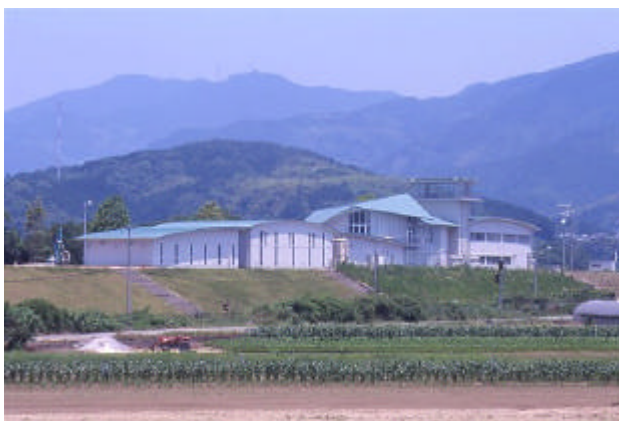
写真 2.1.3(1) 防災ステーション （平成12年7月完成：大洲市若宮）
