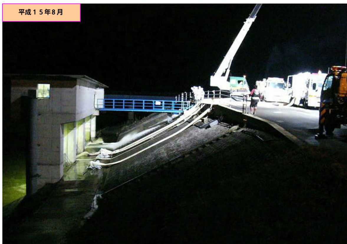
写真4.3.16 都谷川樋門から内水排除をするポンプ車
