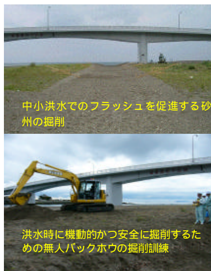
写真 4.3.5 河口砂州管理対策工
