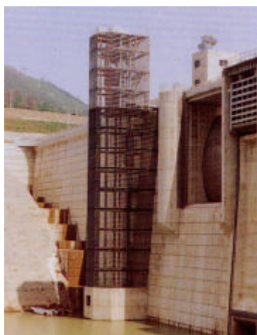
写真 4.2.2 選択取水設備の設置 (野村ダムの事例)
