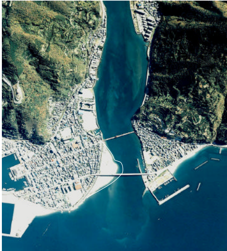
写真 2.1.2 河口砂州フラッシュ状況（平成 7 年 7 月洪水後）
