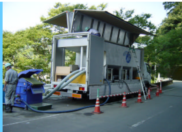
凝集脱水処理装置
