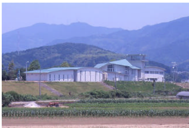
図 2.1.4(1) 防災ステーション (平成 12 年 7 月完成：大洲市若宮)
