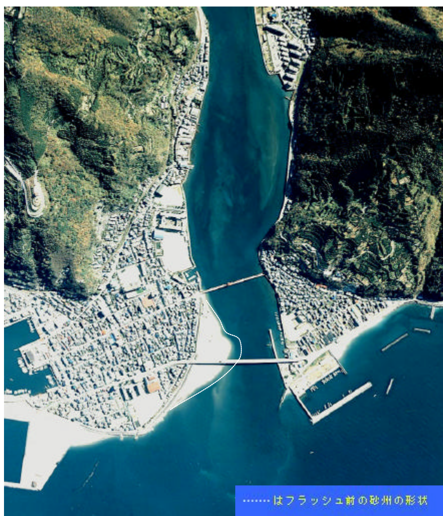
写真 2.1.2 河口砂州フラッシュ状況(平成7年7月洪水後)
