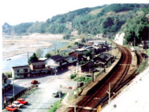
五郎駅前地区施工前(上流より)
