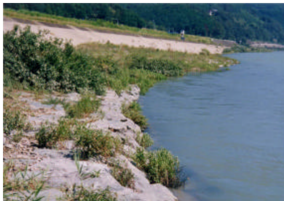
写真 1.2.6 多自然型護岸の整備例
