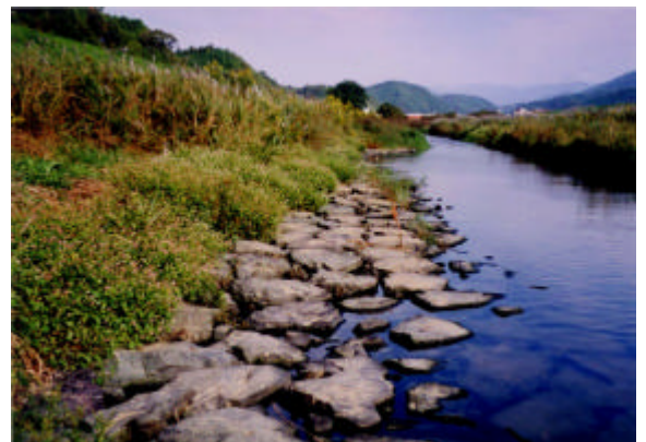
写真 1.2.6 多自然型護岸の整備例
