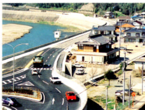
五郎駅前地区完成(上流より)
