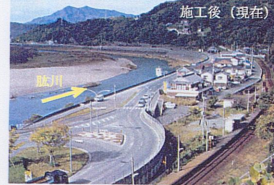
地上げ方式による堤防 (五郎駅前地区)
