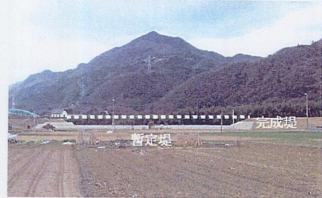
激特事業で一部高さの低い堤防の施工 (豊中地区)
