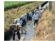
水路の泥上げ
