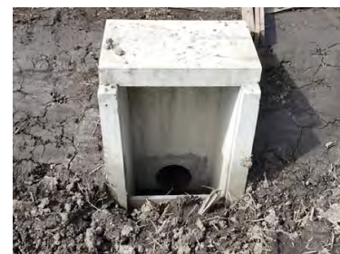
落水口の整備
