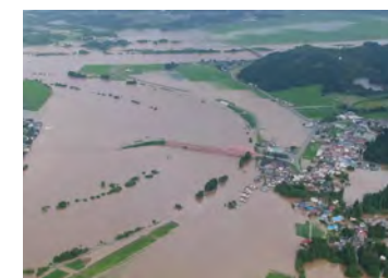
本川からの浸水状況
