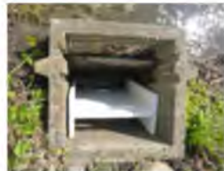
落水口の仕組み
