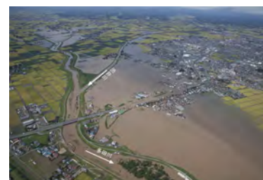
合流部での浸水状況
