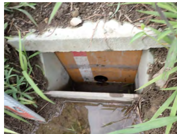
調整板の設置
