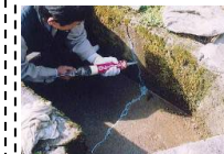
水路のひび割れ補修
