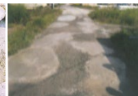
農道の窪みの補修
