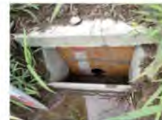
堰板等の購入
