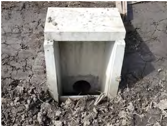
落水口の整備
