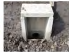
落水口の整備
