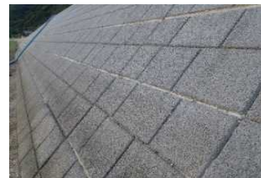
カニ類が移動しやすい粗面護岸
