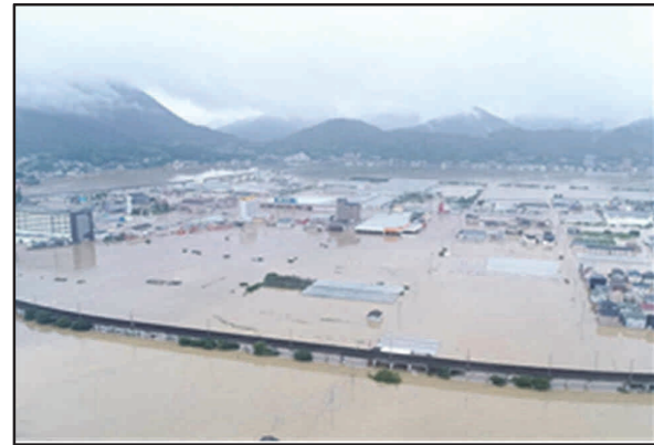
東大洲地区浸水状況（平成30年7月）
