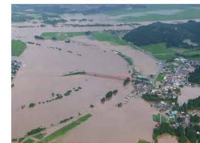
本川からの浸水状況
