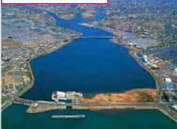
排水機場と周辺の市街地
