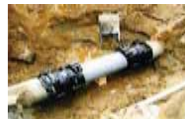
漏水防止のための整備
