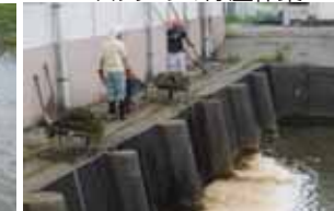
スクリーンの除塵作業
