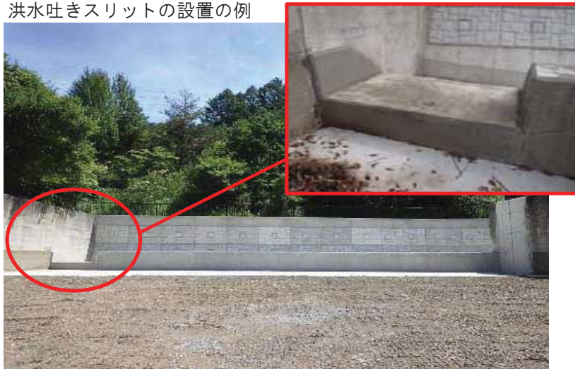
洪水吐きスリットの設置の例
