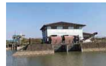
(排水機場整備)
