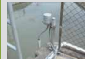
水位計の設置
