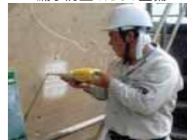
老朽化した施設の機能診断
