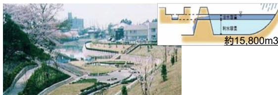
(事例) ため池を改良した流域貯留施設
