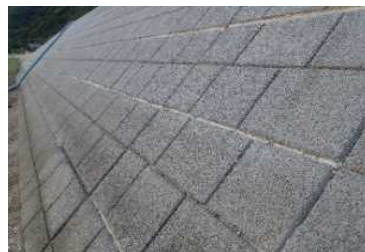
カニ類が移動しやすい粗面護岸
