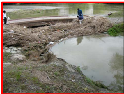
洪水時に発生する塵芥（ゴミ・流木等）が渡河橋にせき止められている状況
