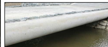
円筒形型枠を使用することで、渡河橋の端部を垂直にせず、塵芥を掛かりにくくし、景観に配慮した。
