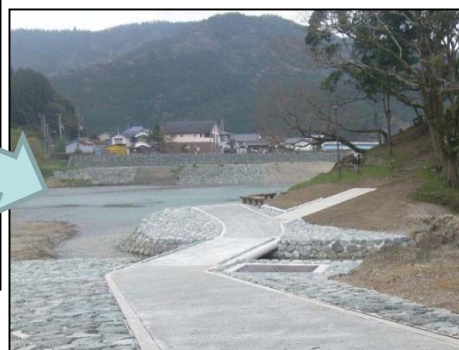
渡河橋及び取水施設を低くし、流下阻害を解消した。
