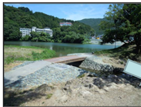
鵜飼いのトイレ休憩所への連絡道となっている現渡河橋 また、大洲市内の水路へ導水している現取水施設（渡河橋手前）
