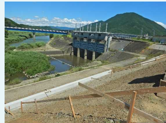
東大洲暫定堤防箇所
