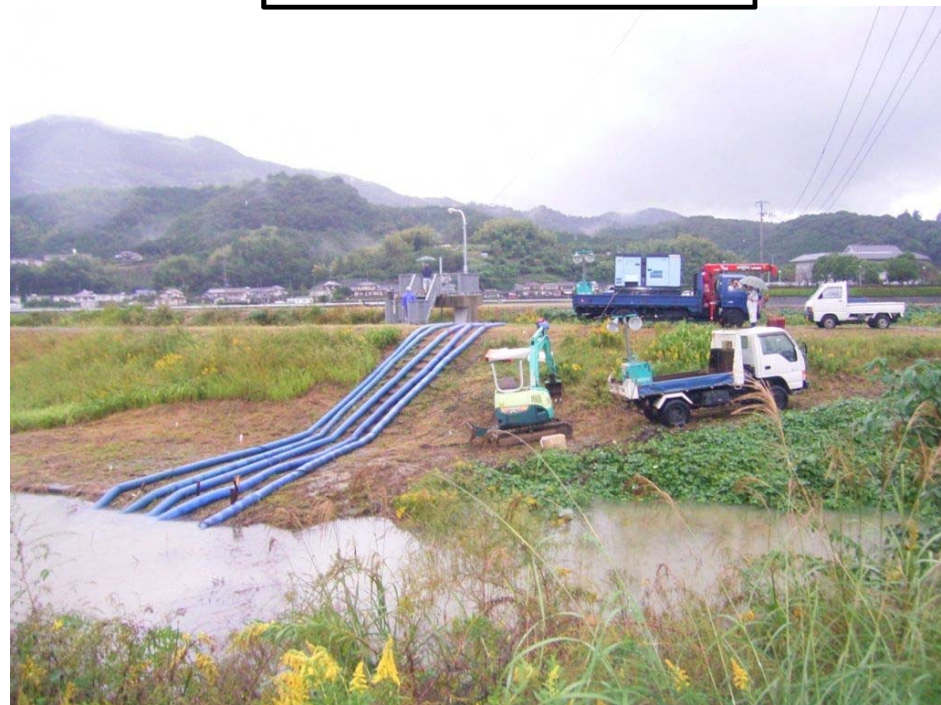
大洲市による西大洲地区のポンプ排水状況
