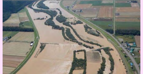
越水による堤防の法崩れ(常呂川)
