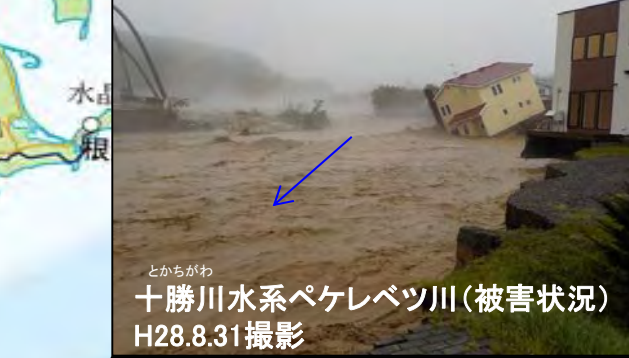
十勝川水系ペケレベツ川(被害状況)H28.8.31撮影
