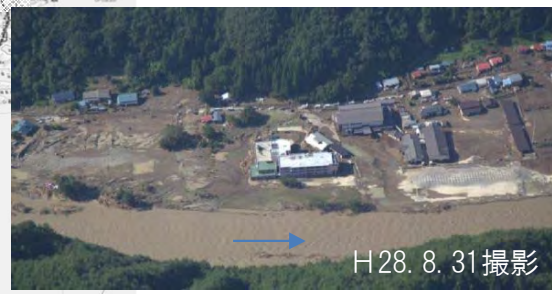
小本川 被害状況①
