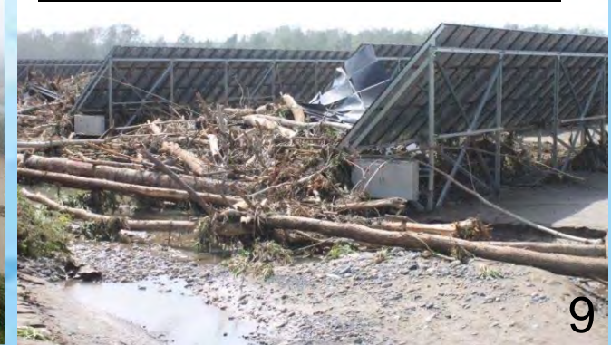
ソーラー発電施設に流木が堆積した様子
