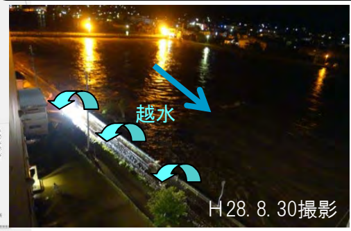
久慈川(右岸)越水状況
