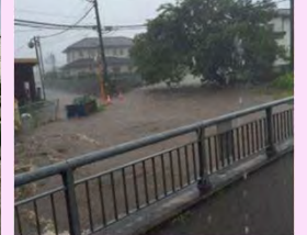
不老川の出水状況 (埼玉県狭山市)
