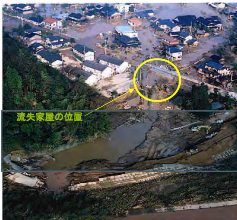
堤防決壊に伴い木造家屋が倒壊した状況
