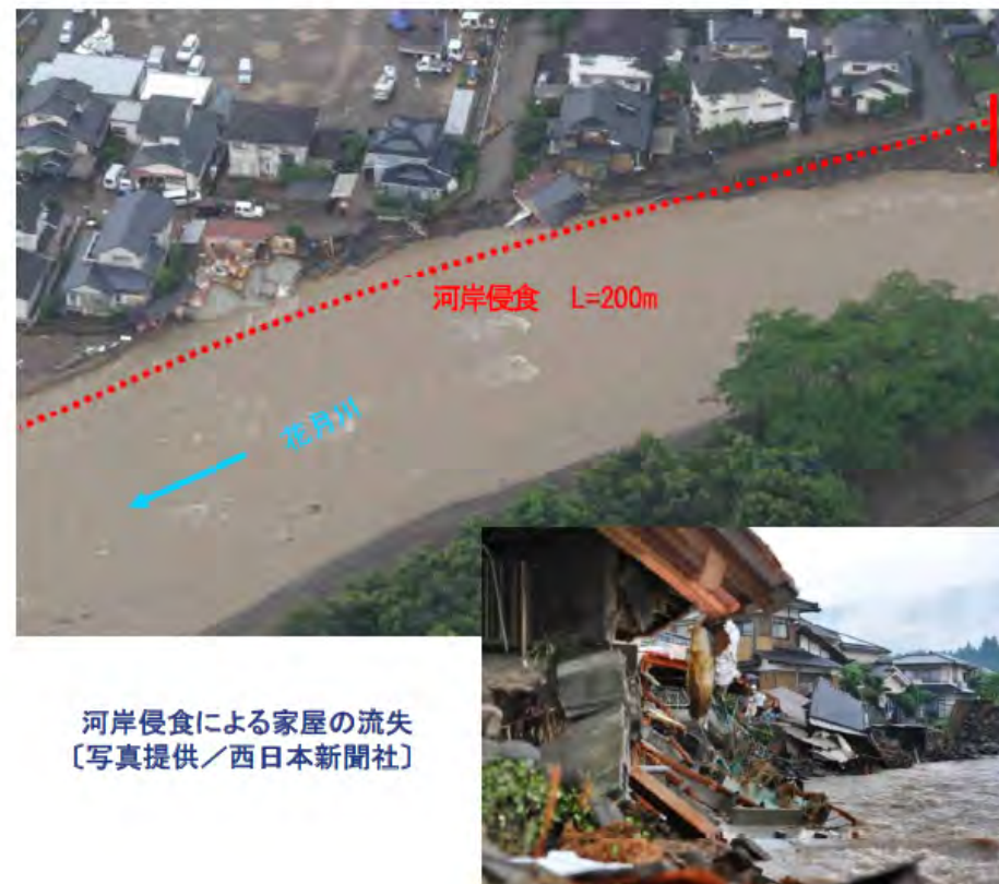
河岸侵食により家屋倒壊した状況
