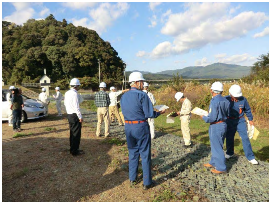
重要水防箇所の共同点検状況
