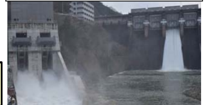
鹿野川ダムトンネル洪水吐 通水の様子
