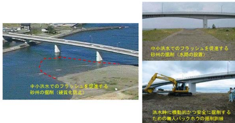
図 2-2 河口砂州の管理対策工
