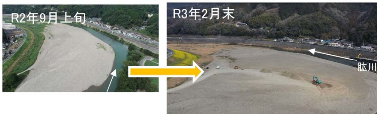
図 3-2 維持掘削状況（慶雲寺箇所）
