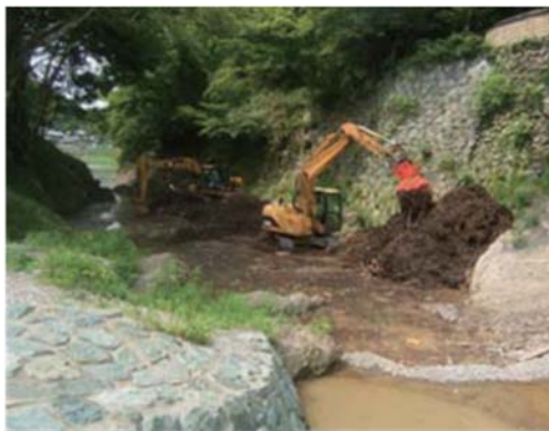
洪水時に漂着した流木等の処理（塵芥処理）
