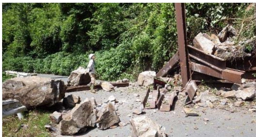
平成28年7月 主要地方道小田河辺大洲線の法面崩落
