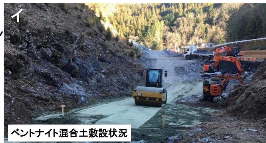
下敷水残土処理場に底面遮水工を施工
