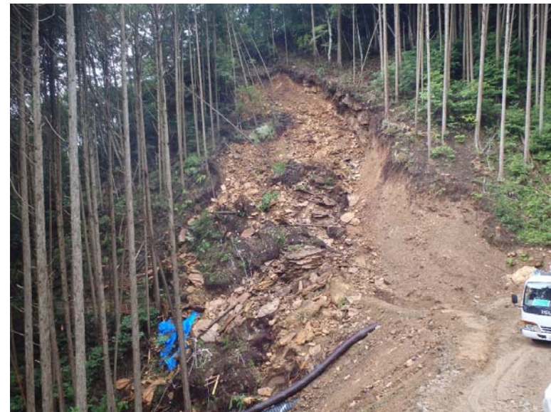
法面崩落への対応
