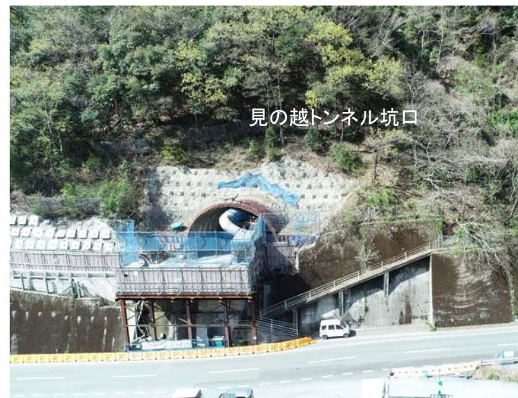
見の越トンネル坑口(終点側) 施工中(令和4年4月)
