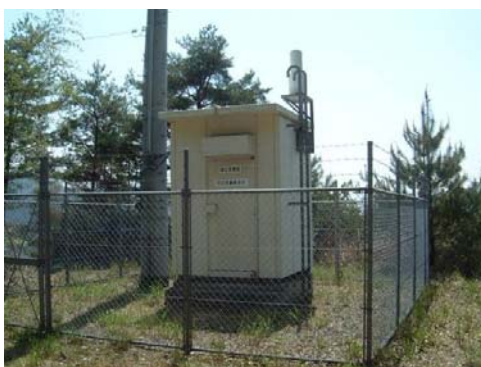
写真 4.3.9 テレメータ雨量観測局舎
