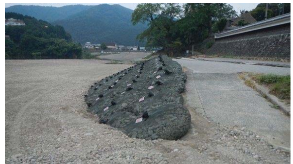
被災箇所の応急復旧
