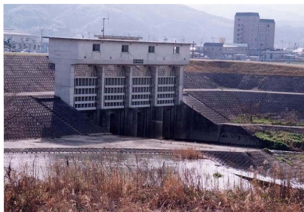
写真 4.3.6 (2) 都谷川排水樋門 (矢落川 0.8k 左岸)
