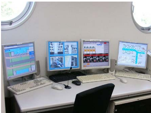
写真 4.3.14 (1) 遠隔操作監視システム
