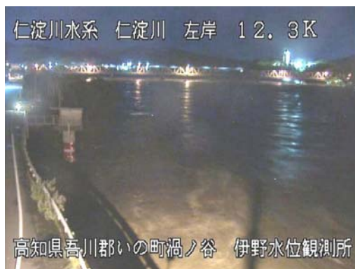
▲仁淀川橋付近 (平成29年9月17日22:30頃) 同時刻の伊野水位観測所水位：7.22m
