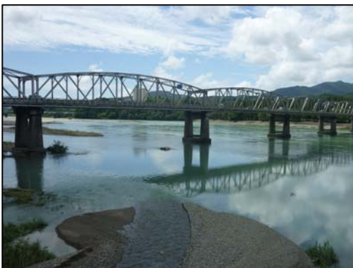
▲平常時の仁淀川橋付近 平常時の伊野水位観測所水位：約 1m
