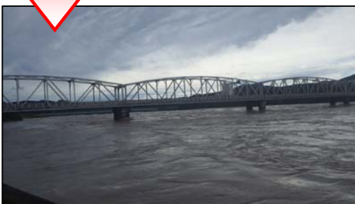
▲仁淀川橋付近 (平成 26 年 8 月 10 日 8 : 10 分頃) 同時刻の伊野水位観測所水位：8.06m
