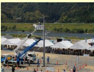
四国電力、NTTによる ライフライン復旧訓練
