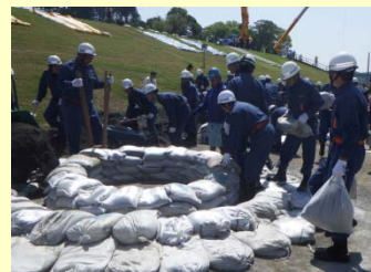
宿毛市の水防団による 水防工法（釜段工）
