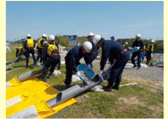
四万十市の水防団による 水防工法（水防マット工）
