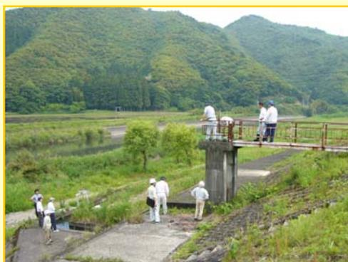
5月20日(月)、22日(水)に中村河川国道事務所において、出水期を前にした樋門点検を実施しました。樋門は洪水時に本川からの水の逆流を防ぐ施設で、今回の点検では、樋門ゲートが正常に動作するか、確実に止水するか等の項目について、点検を実施しました。梅雨に入りこれから雨の多い時期になりますが、これからも地域の安心・安全に努めてまいります。
