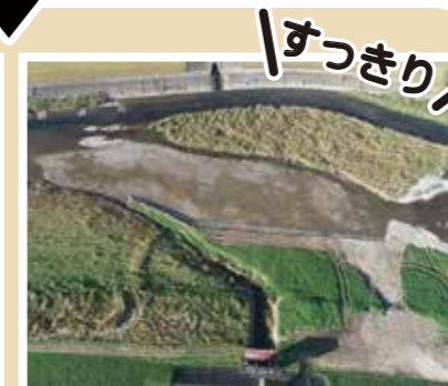
後川右岸 4k400 川家川樋門付近
