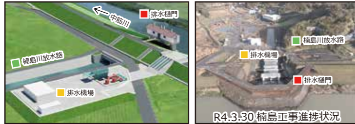
R4.3.30 楠島工事進捗状況
