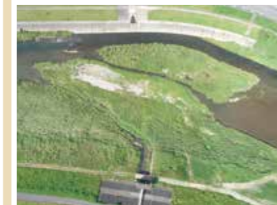
後川右岸 4k400 川家川樋門付近
