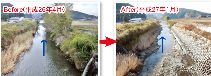
仁井田橋より下流
