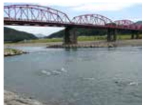
四万十川橋（通称：赤鉄橋）
