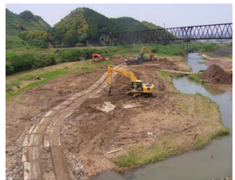
写真4.2.2 土砂の撤去状況
