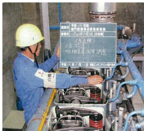
写真4.2.7 樋門の設備点検状況
