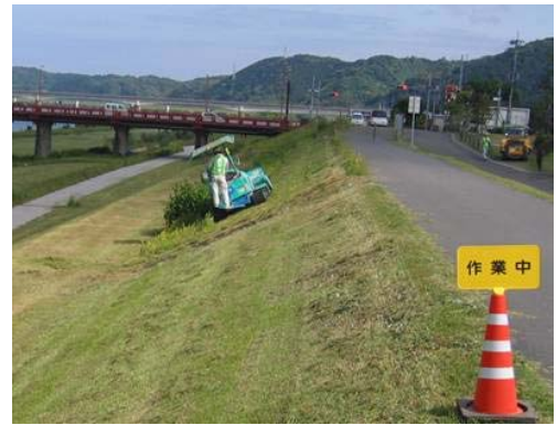
写真4.2.4 堤防除草の状況
