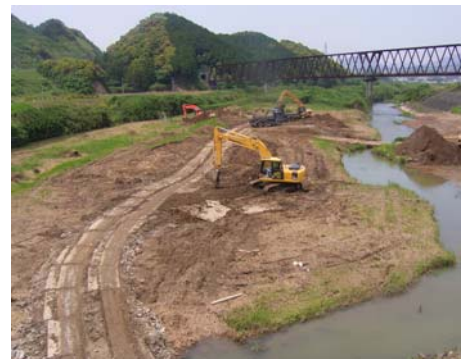
写真4.2.2 土砂の撤去状況
