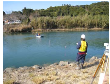
写真4.2.3 河川縦横断測量状況
