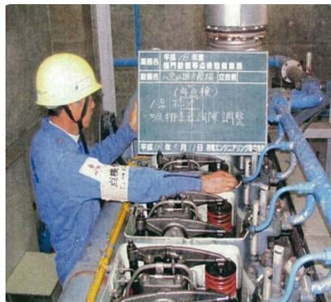
写真4.2.7 樋門の設備点検状況
