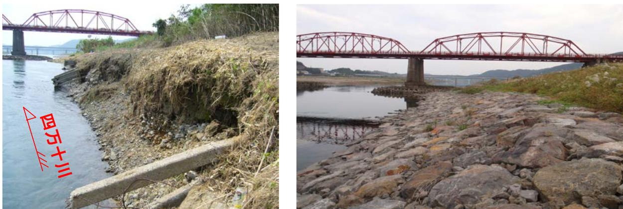
図4.2.5 平成19年7月洪水による具同箇所の護岸被災状況（左）と対策状況（右）
