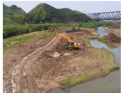
写真4.2.2 土砂の撤去状況
