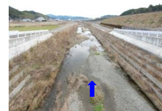
井関ハナ橋より下流河道
