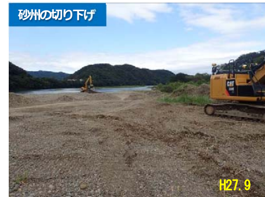
図 3-6 入田地区の砂州の切り下げ、置き土の状況
