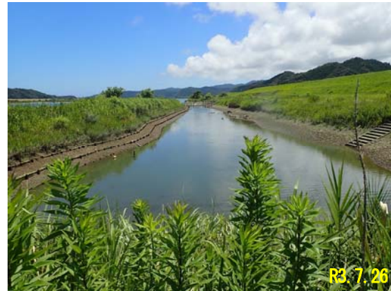
図5-7 実崎再生工事箇所の状況
