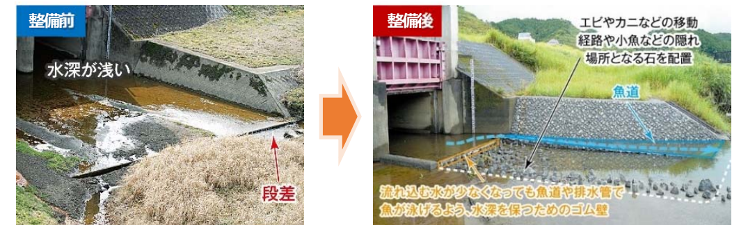
図 2-2 河川の連続性の確保(樋門の段差解消)の整備前後の状況(九樹樋門の例)
