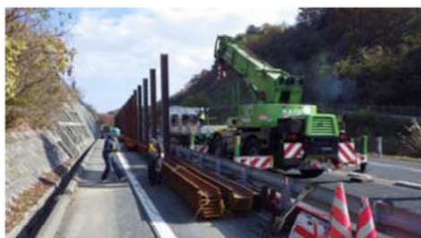
【仮設防護柵】 （施工イメージ）
