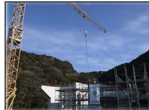
↑ 定置式水平ジブクレーンと施工現場の全景
