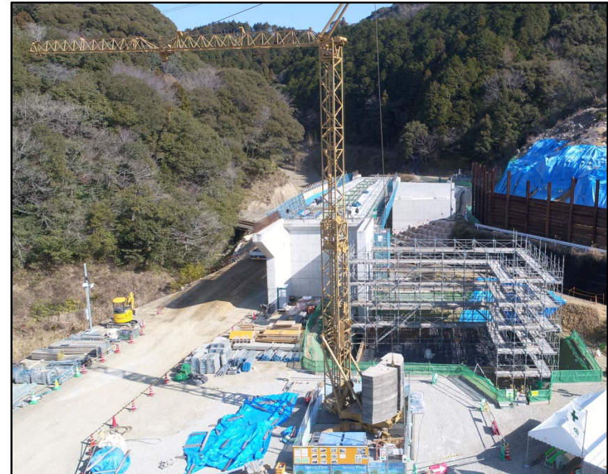
↑ 定置式水平ジブクレーンと施工現場の全景
