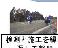
丁張りに合わせて 施工
