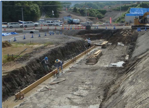
〈擁壁の施工(基礎工)状況〉
