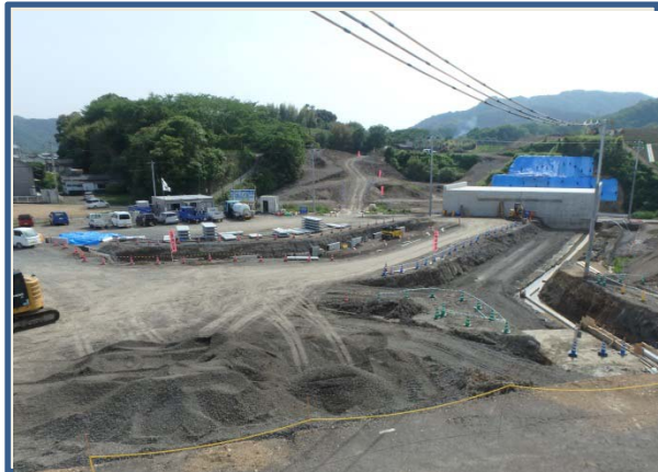
〈擁壁の施工(壁面材設置)状況〉
