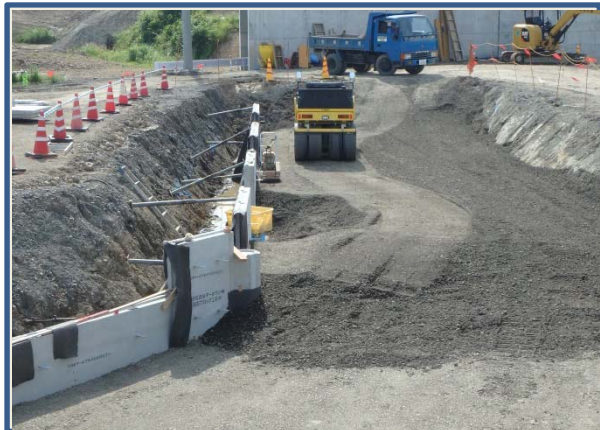
〈擁壁の施工(壁面材設置)状況〉
