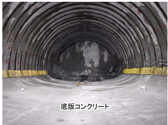
〈トンネル坑内(底版コンクリート施工済区間)〉
