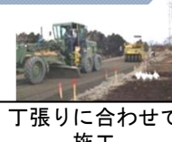
検測と施工を繰り返し整形
