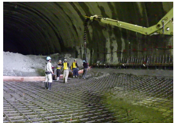
〈底版コンクリートの打設状況〉
