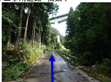
④ 工事用道路 橋梁下
