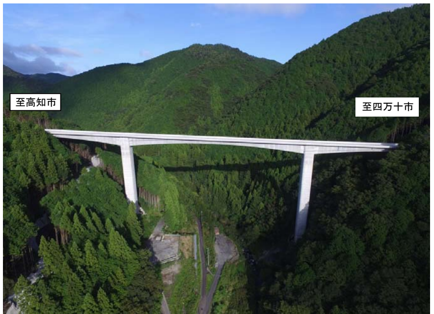
市野瀬橋側面より
