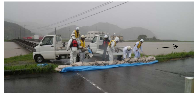
有岡箇所(中筋川)での四万十市消防団中村方面隊中筋分団による水防活動状況[土のう積み工]
