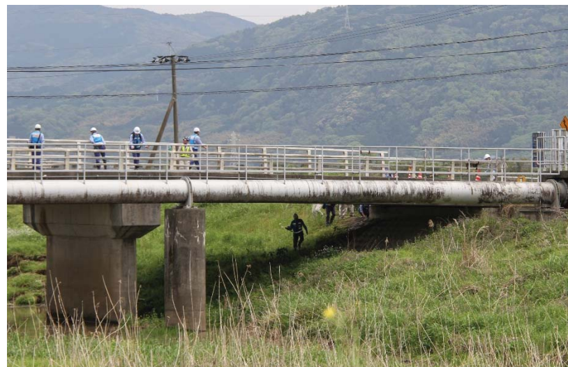
橋梁点検概要（上沼山津橋）
