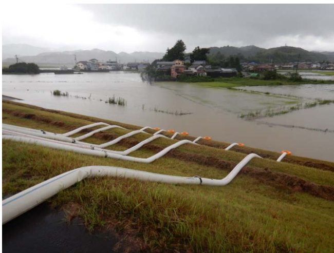
■排水ポンプ車(60m 3 /min) 後川3k/600付近(安並地先)
