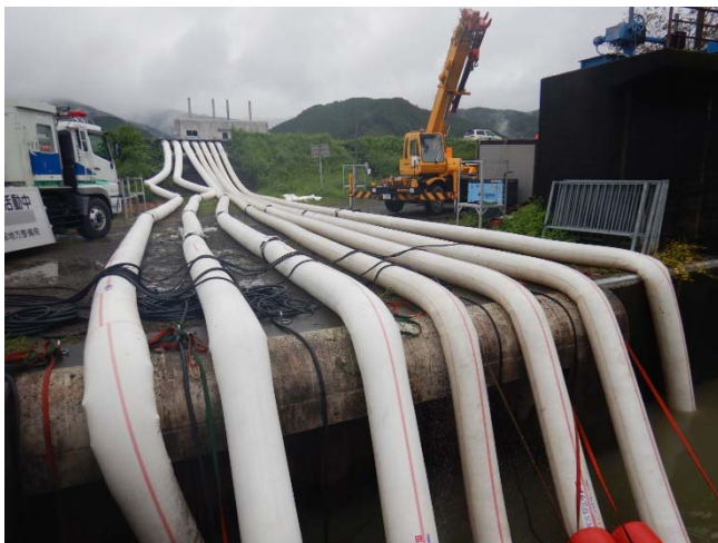
■排水ポンプ車(150m 3 /min) 中筋川8k/400付近(清水樋門)
